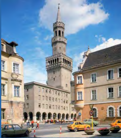
Mitte der neunziger Jahre des zwanzigsten Jahrhunderts wurde das Rathaus in Oppeln umfassend saniert und teilweise erneut umgebaut.
